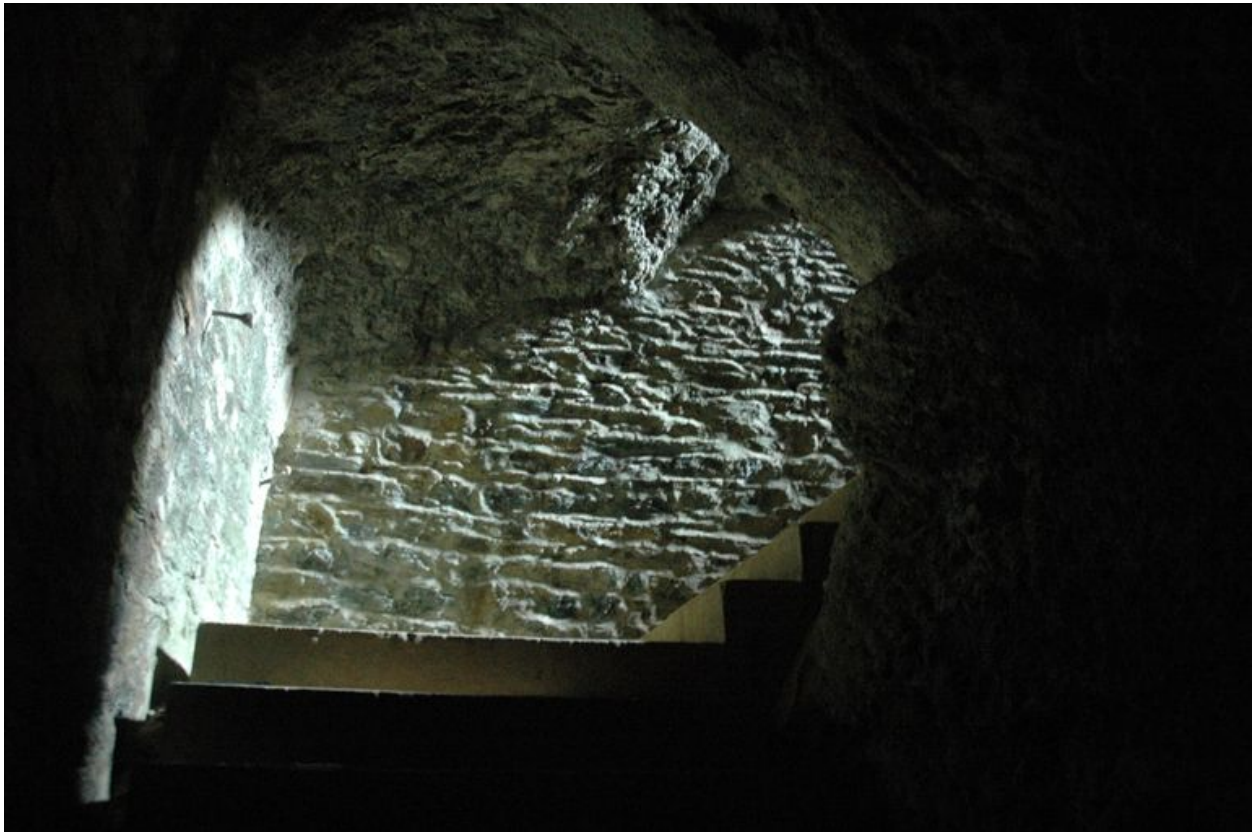
Vue de l'escalier - galerie d'accès (état en 2005)
