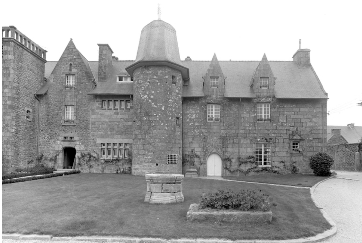
Corps de bâtiment ancien : élévation ouest
