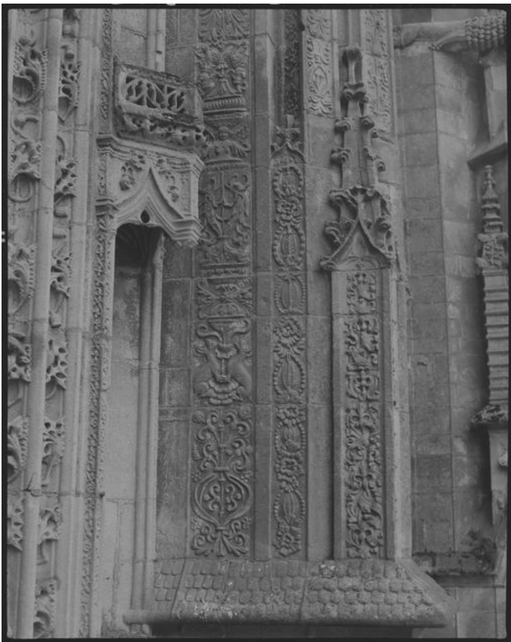
Porche nord, contrefort droit
