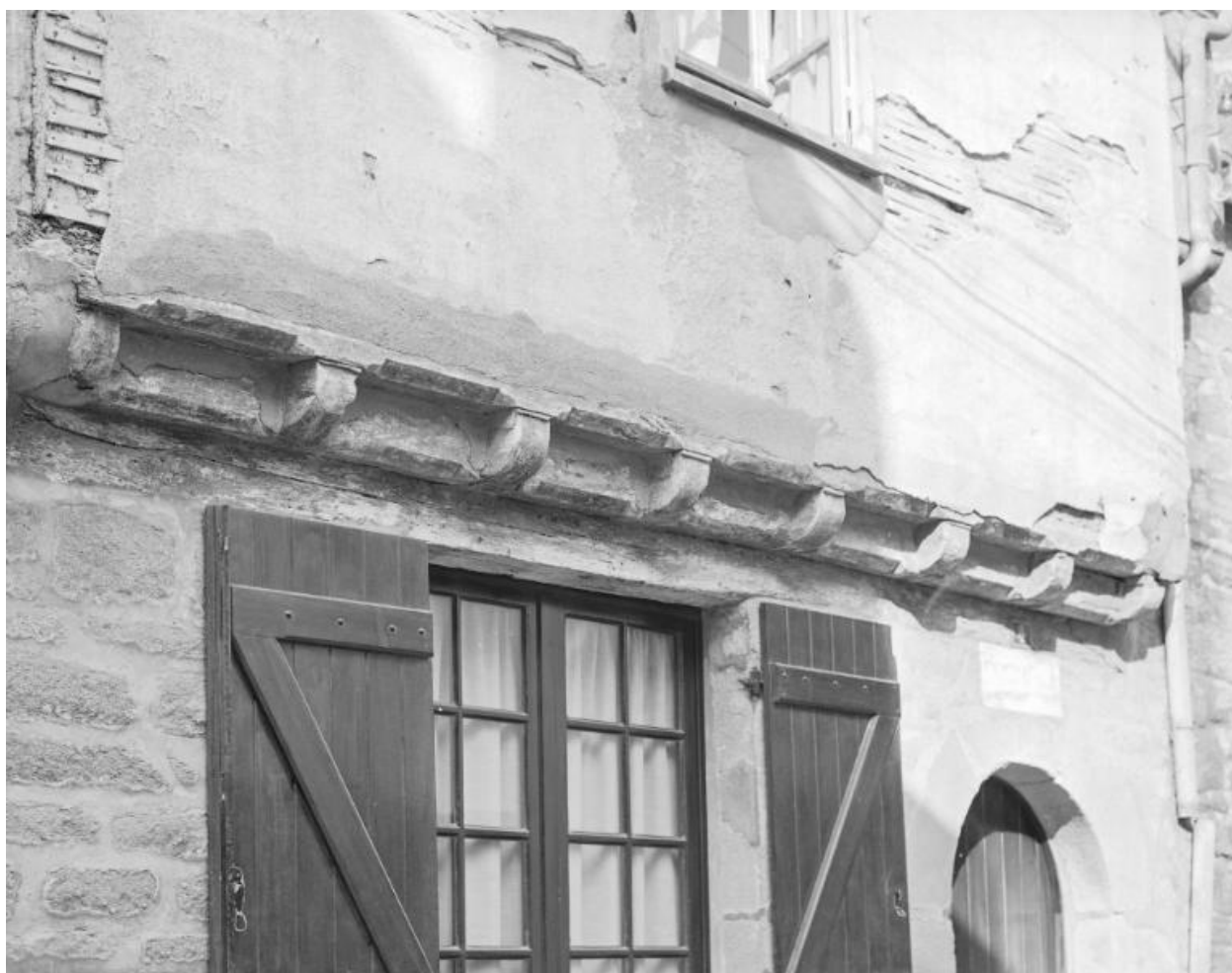
Détail de l'encorbellement sur solives avec entretoises.
