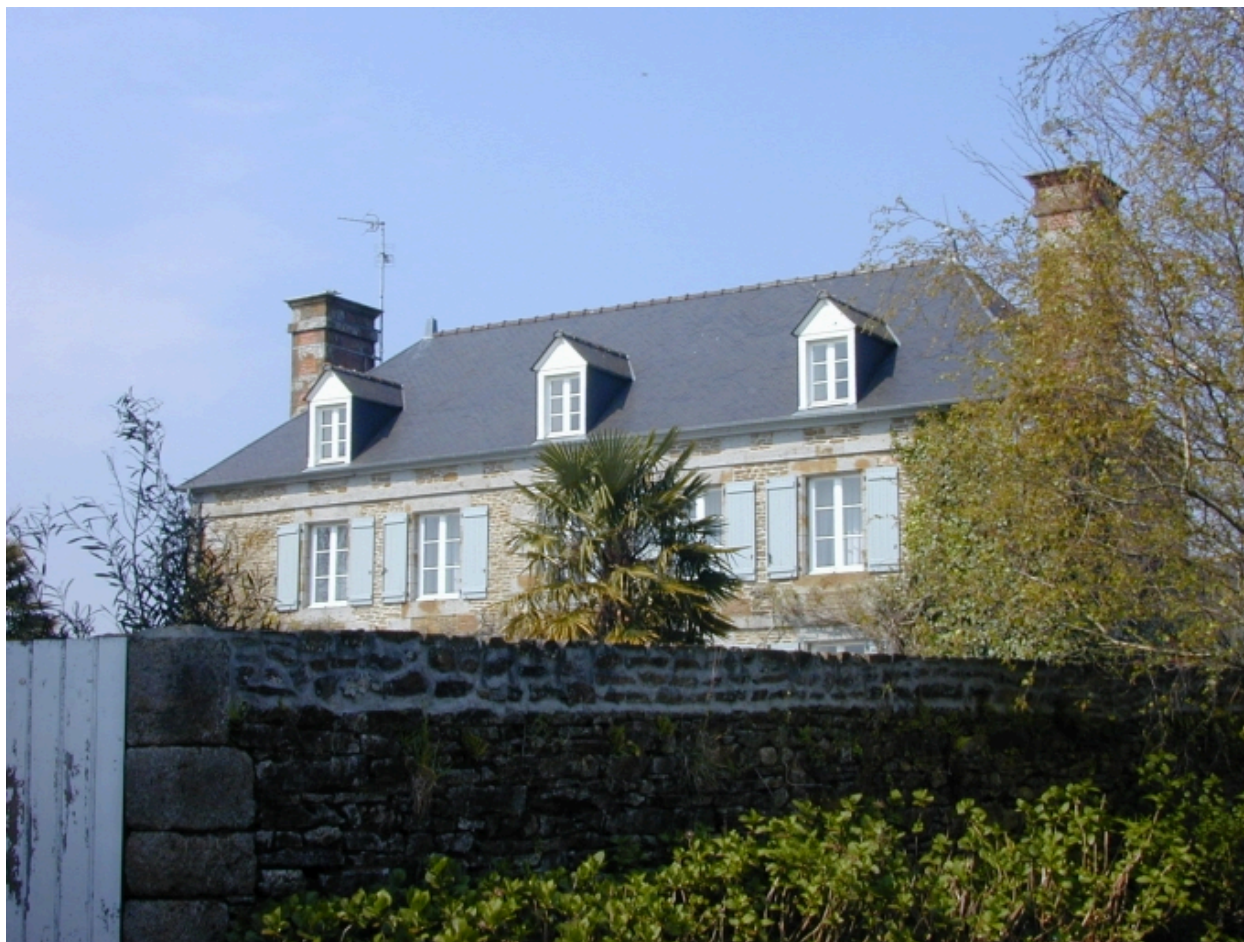
Vue partielle sud-est
