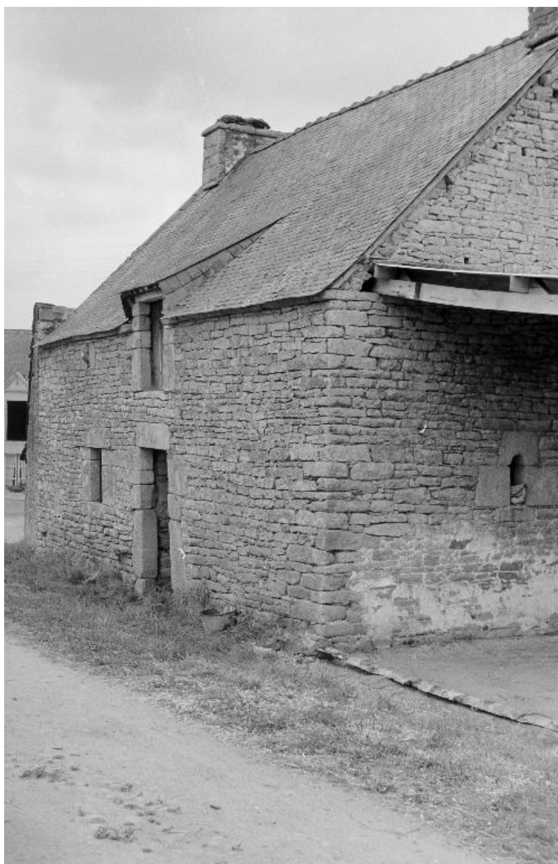
Ferme 50 (état en 1969)
