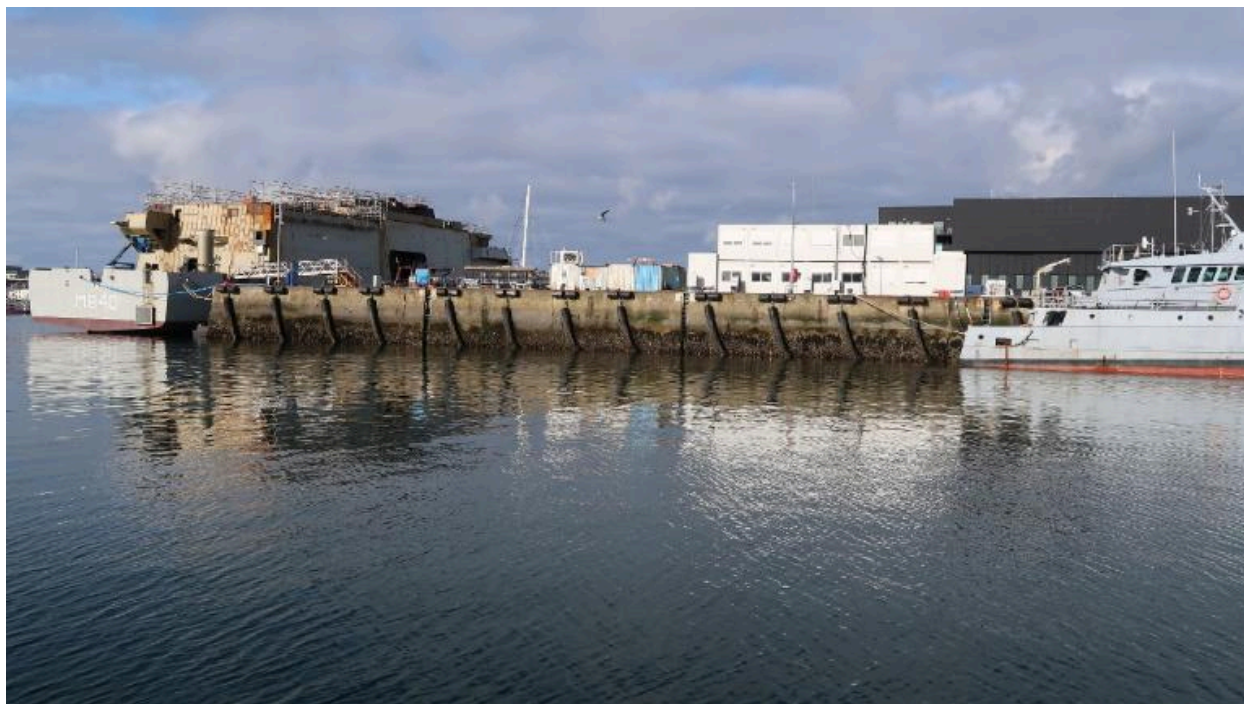
Aire de réparation navale : quai Pétrolier
