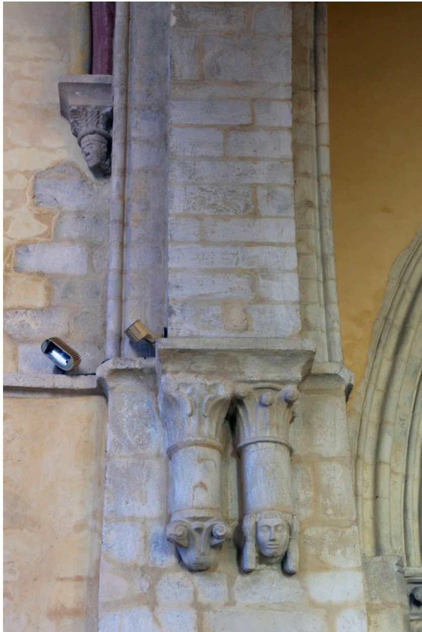
Arc de la tour-clocher, culots sculptés du côté nord
