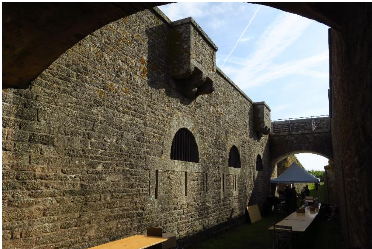
Archipel de Glénan, batterie de Penfret, corps de garde crénelé, façade sud.
