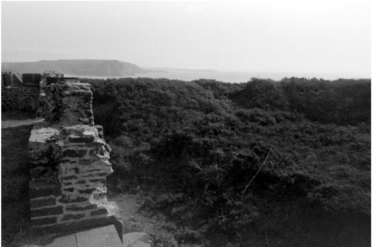
Vue de la batterie de l'île de l'Aber depuis la terrasse du corps de garde crénelé en 1972
