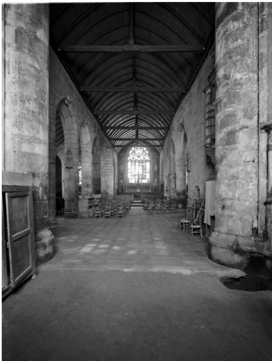
Vue générale du vaisseau central vers l'est
