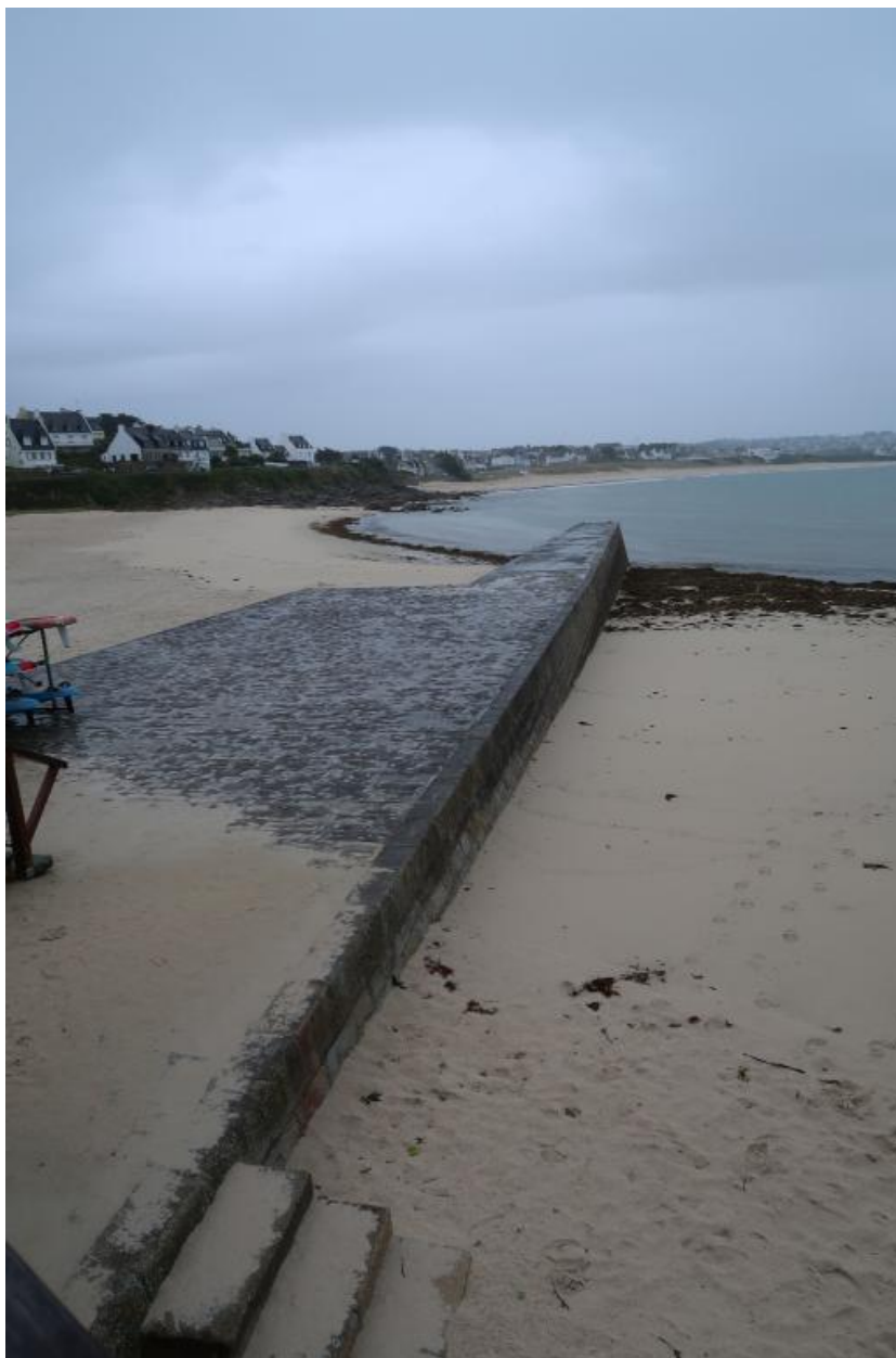
Ancienne digue de Sainte-Evette, depuis le club nautique
