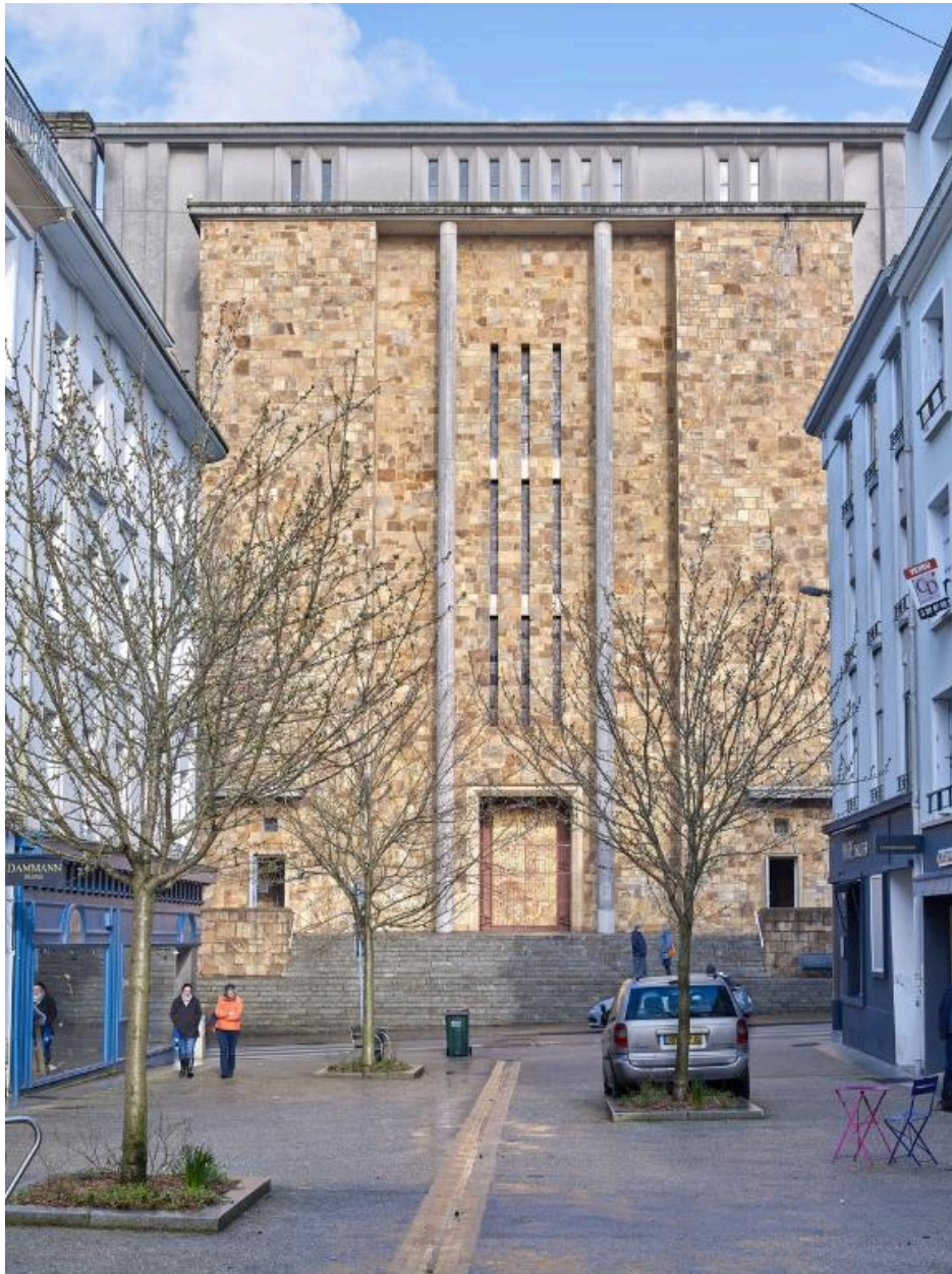
Eglise Saint-Louis, élévation nord
