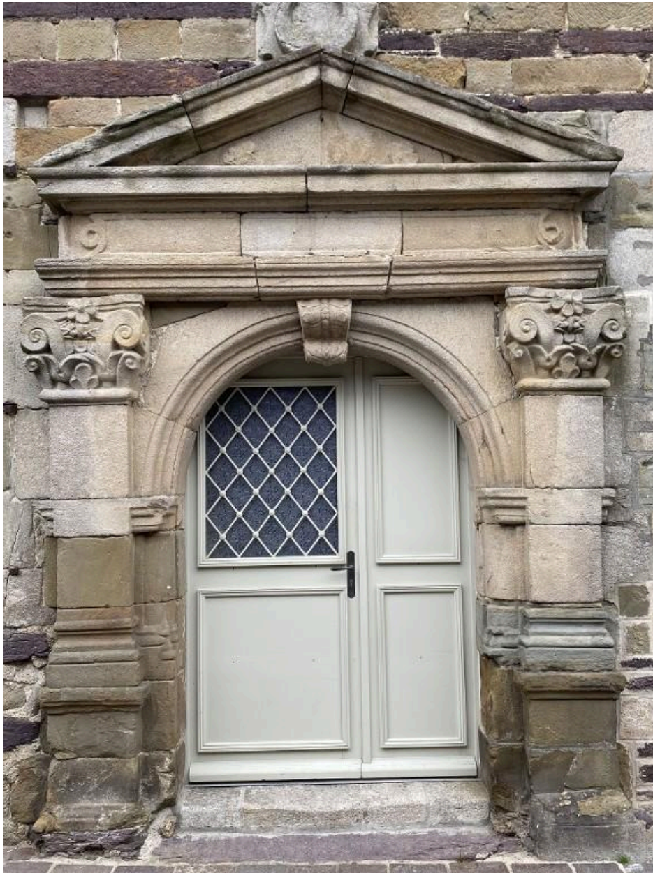
Porte, détail, façade est
