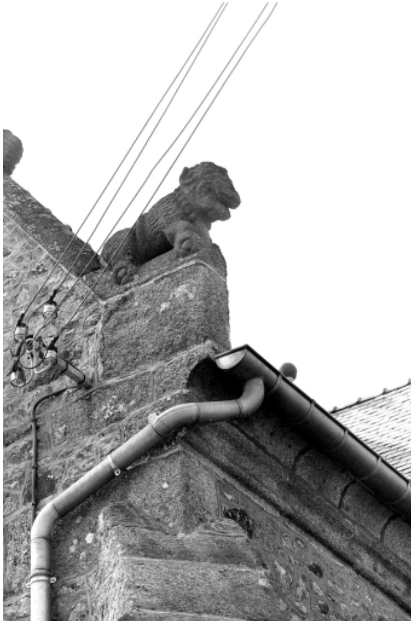
Façade est, détail crossette nord.
