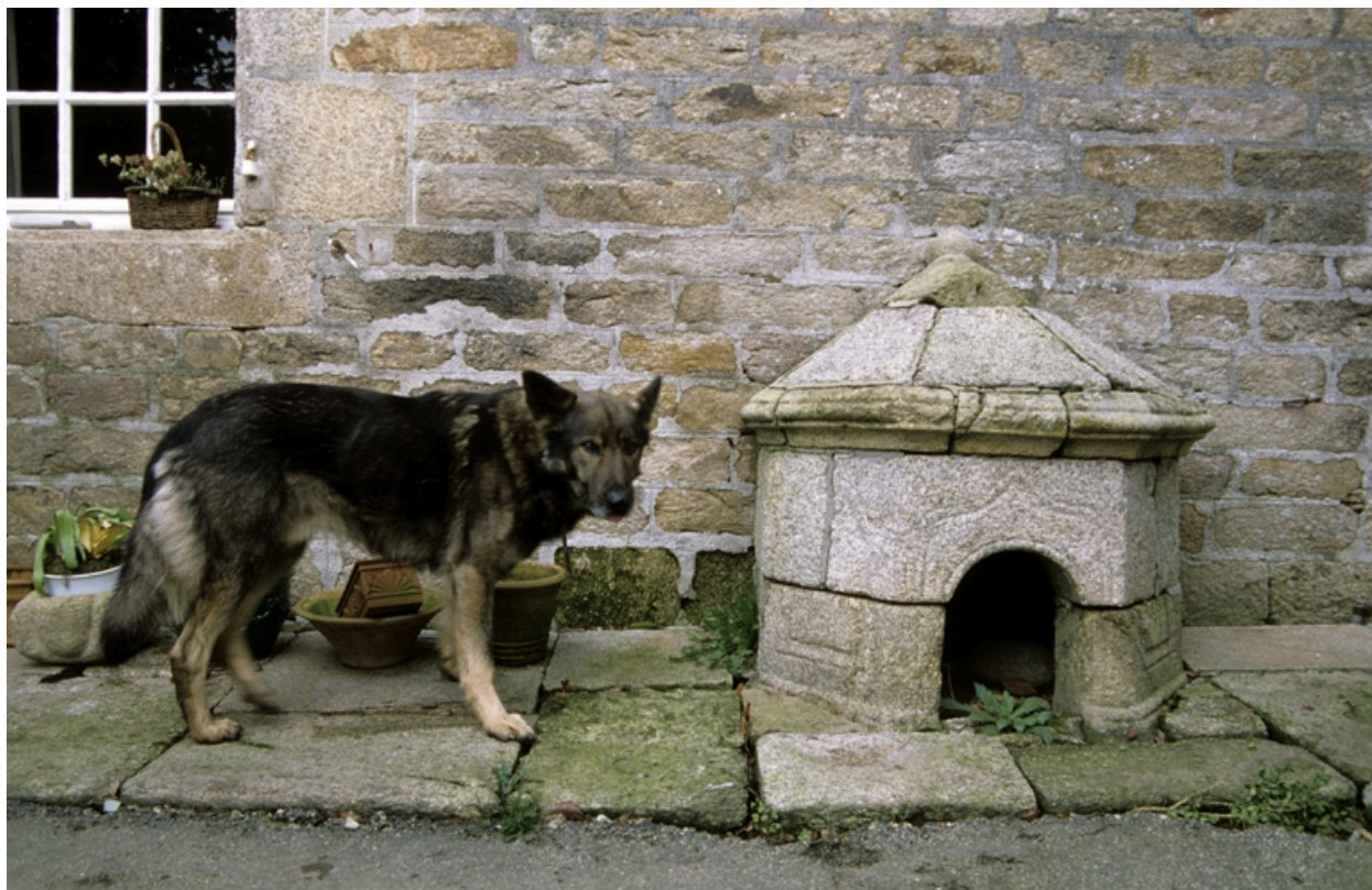
Elévation sud, détail de la niche à chien.
