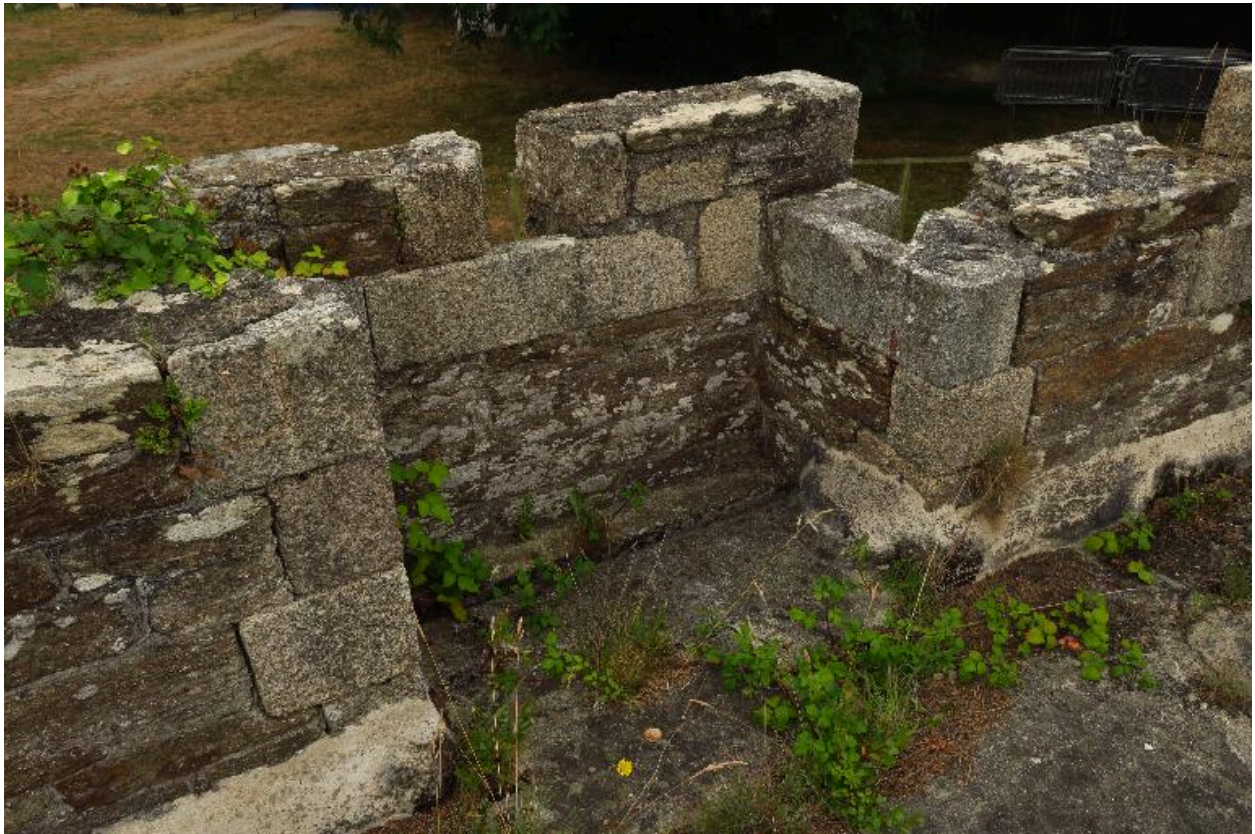
Groix, batterie du Gripp, corps de garde crénelé, détail d'une bretèche de la terrasse.
