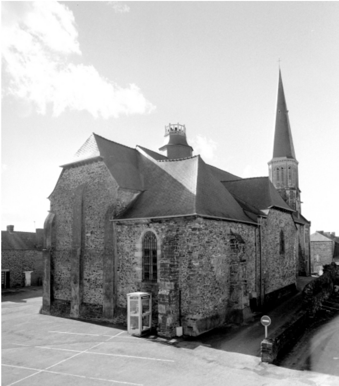
Elévation Nord-Est : vue générale
