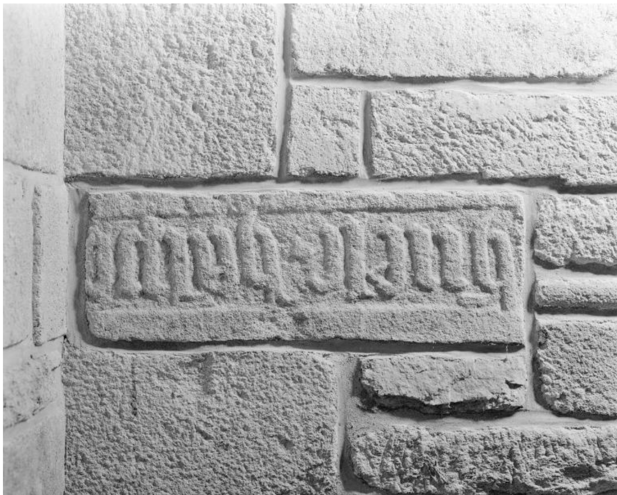
Bras nord, mur nord. Détail d'une inscription en remploi.
