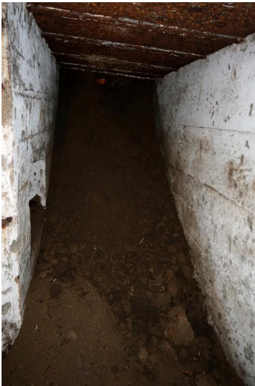
Vue de l'entrée sud remblayée. A gauche (mur nord), au ras du sol, niche murale
