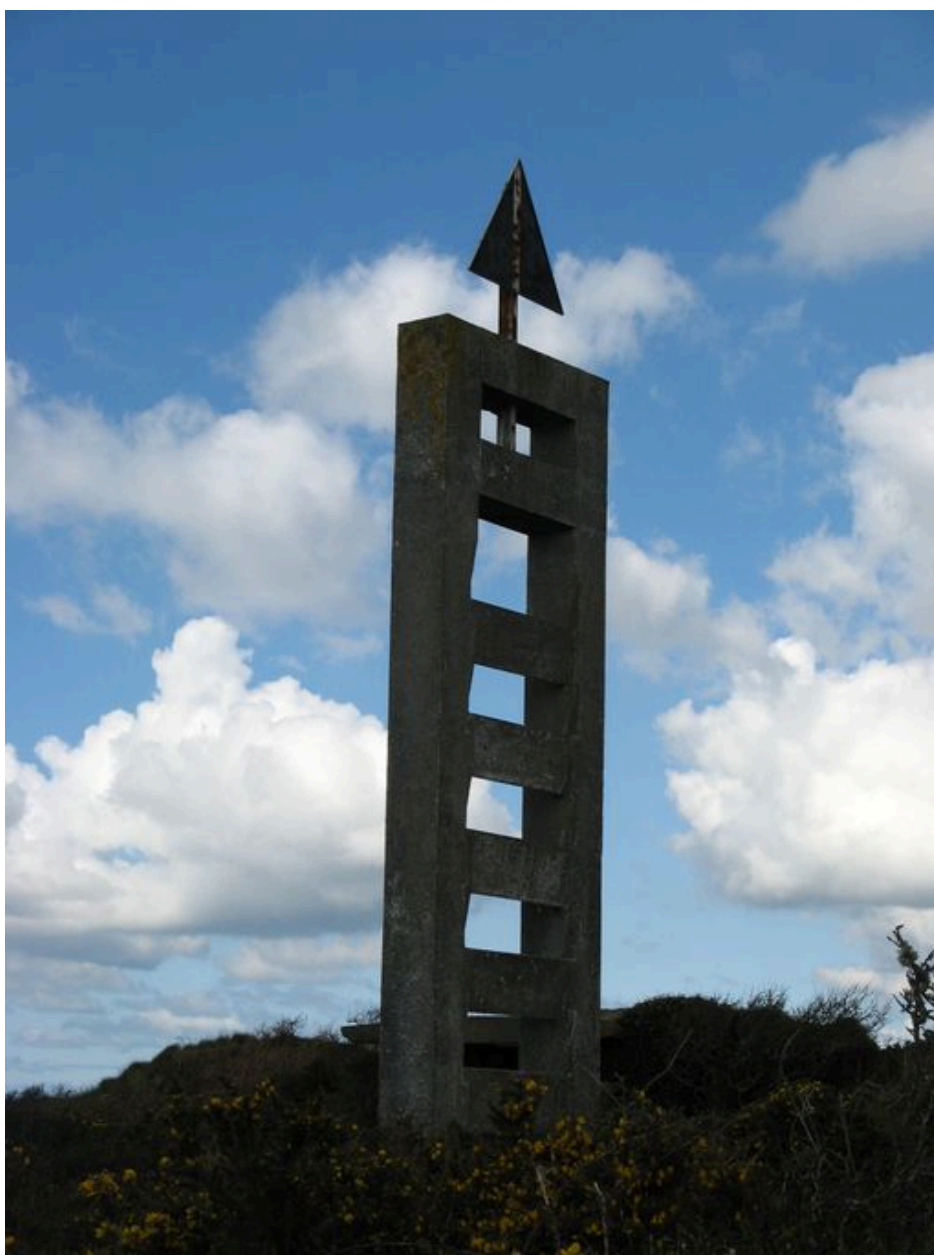
Signalisation et surveillance des côtes : amer de la pointe de Cornouaille (Roscanvel)
