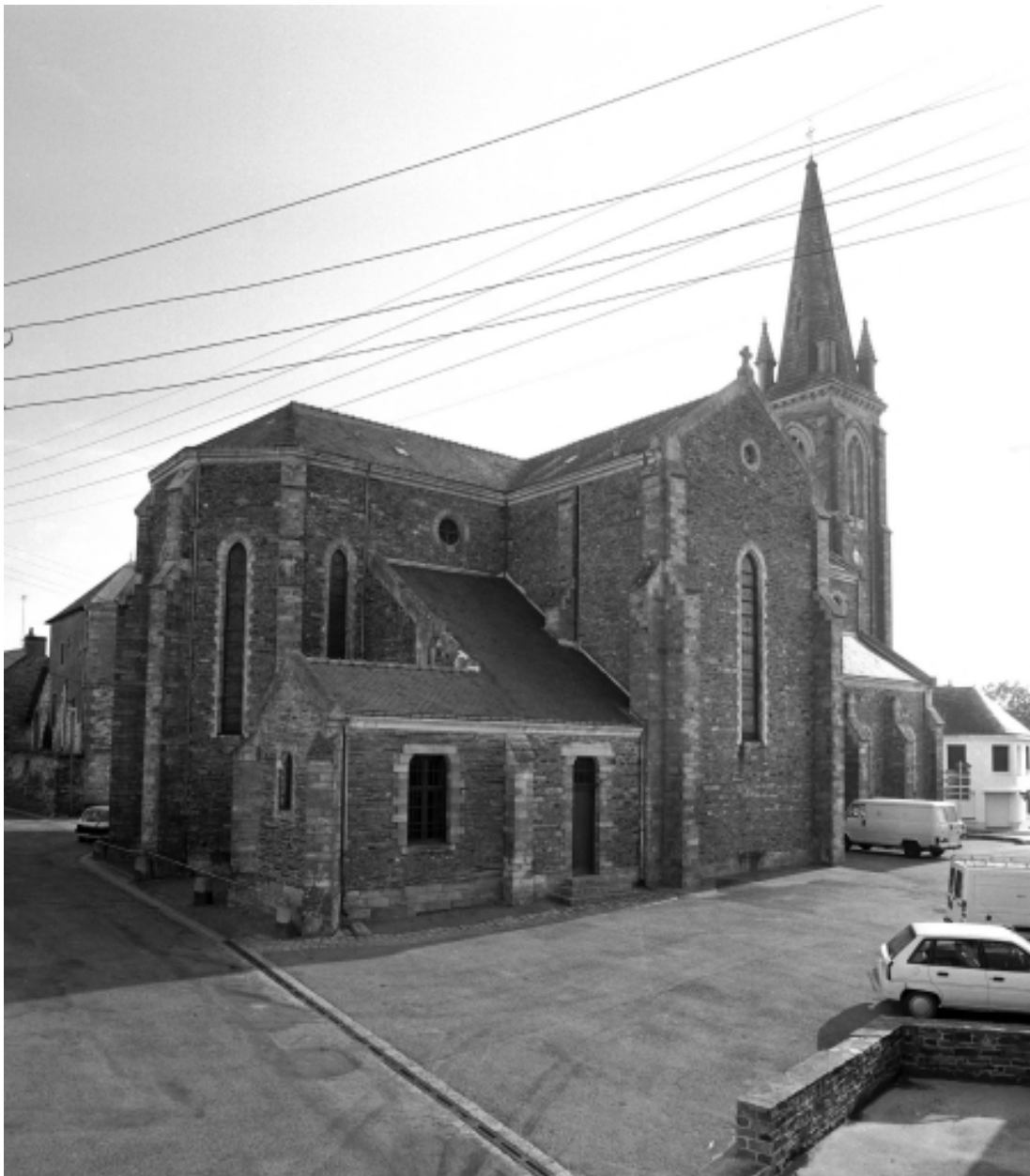
Le choeur : vue générale sud-ouest
