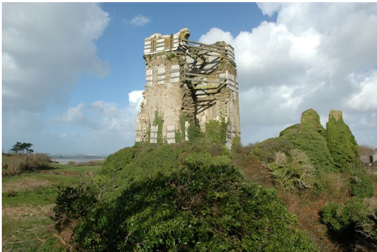
Vue générale du château fort de Trémazan
