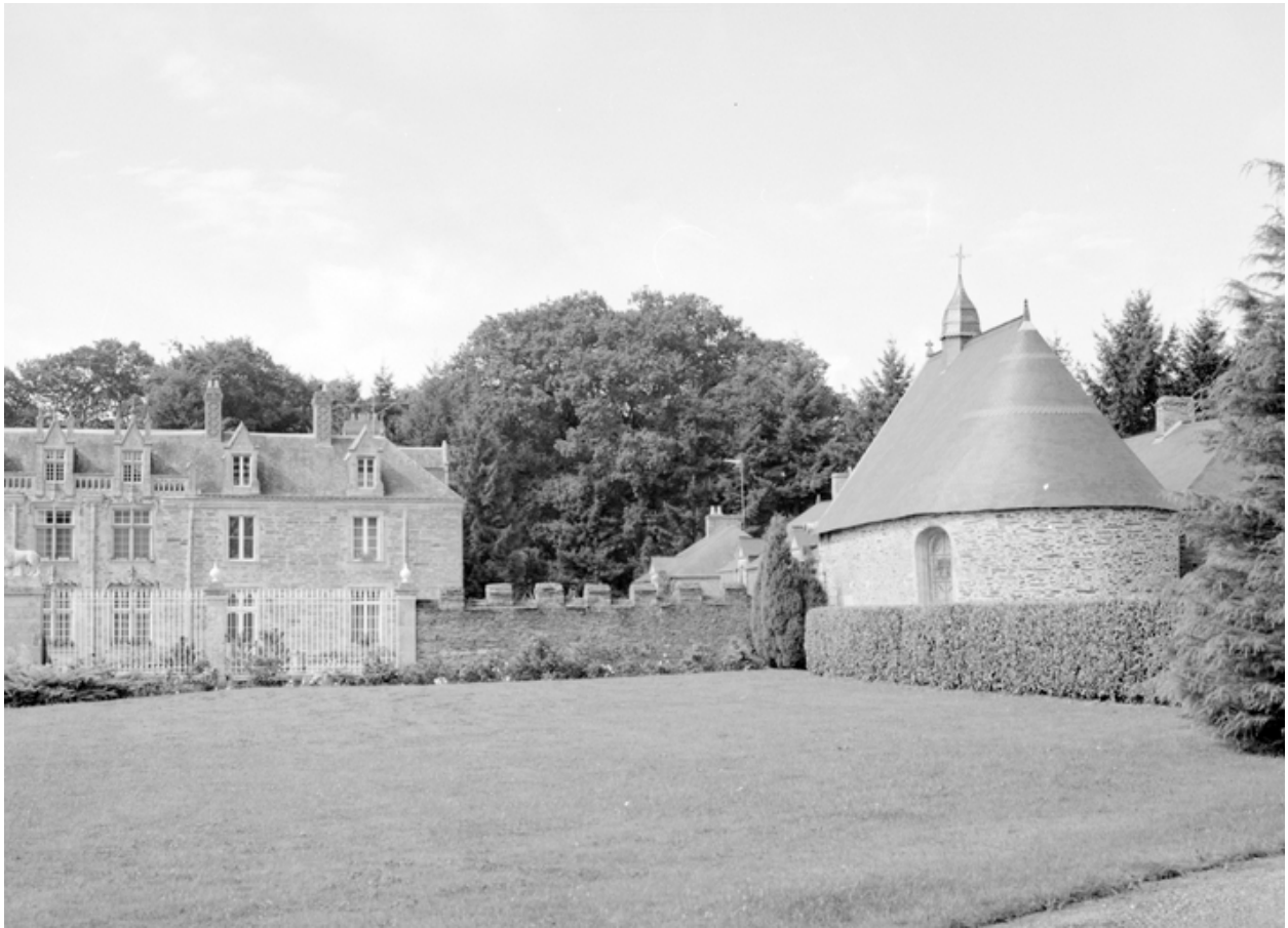
Chapelle : vue de situation
