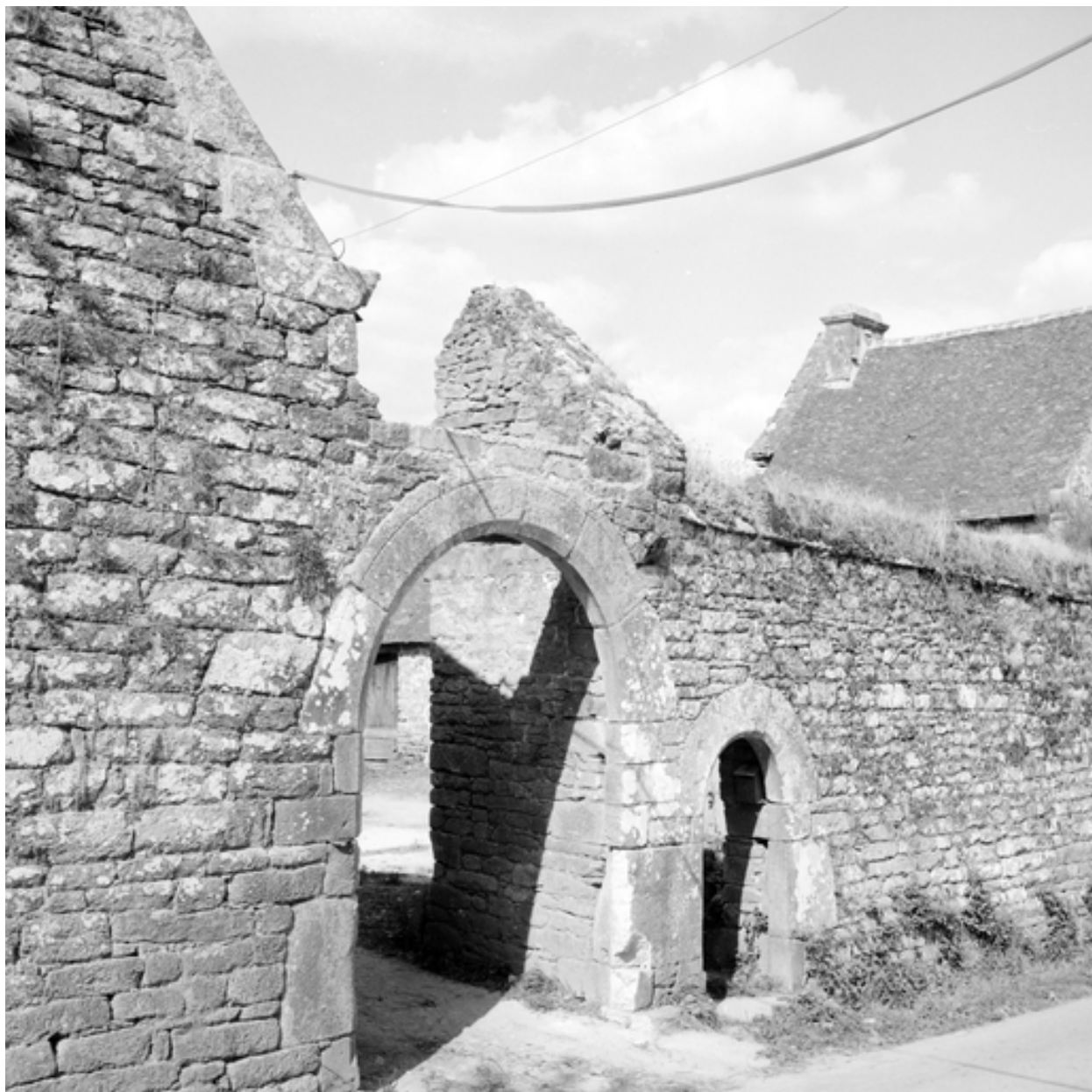
Double entrée du mur de clôture sud
