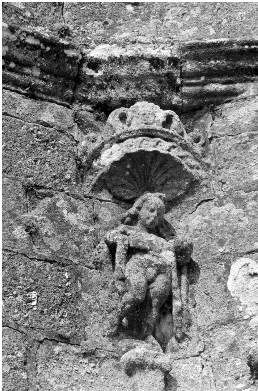
Clocher, face ouest, colonne nord de la porte : détail de la figure sculptée
