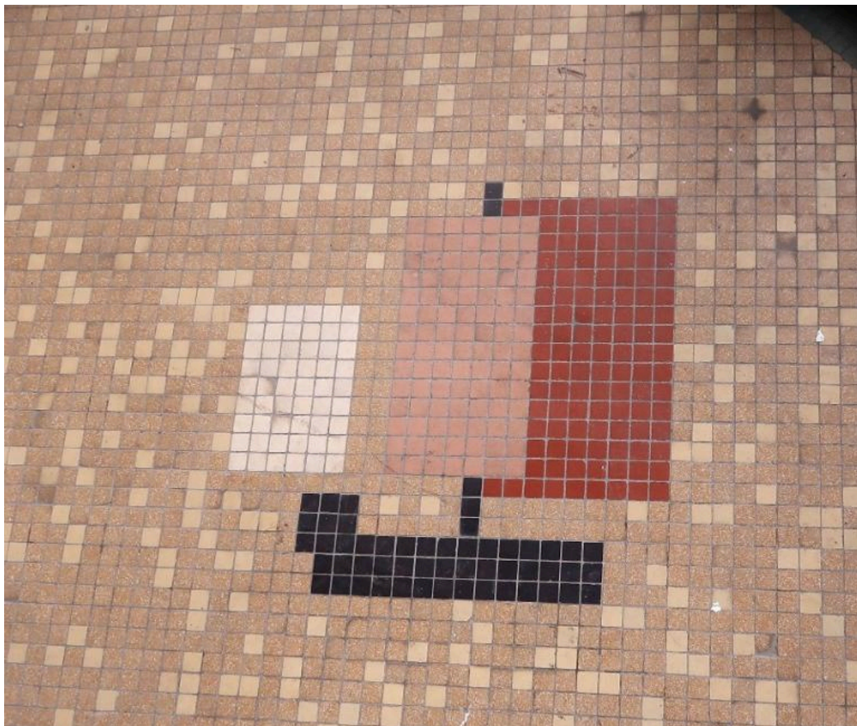
Criée de Concarneau : décor en carreaux de ciment
