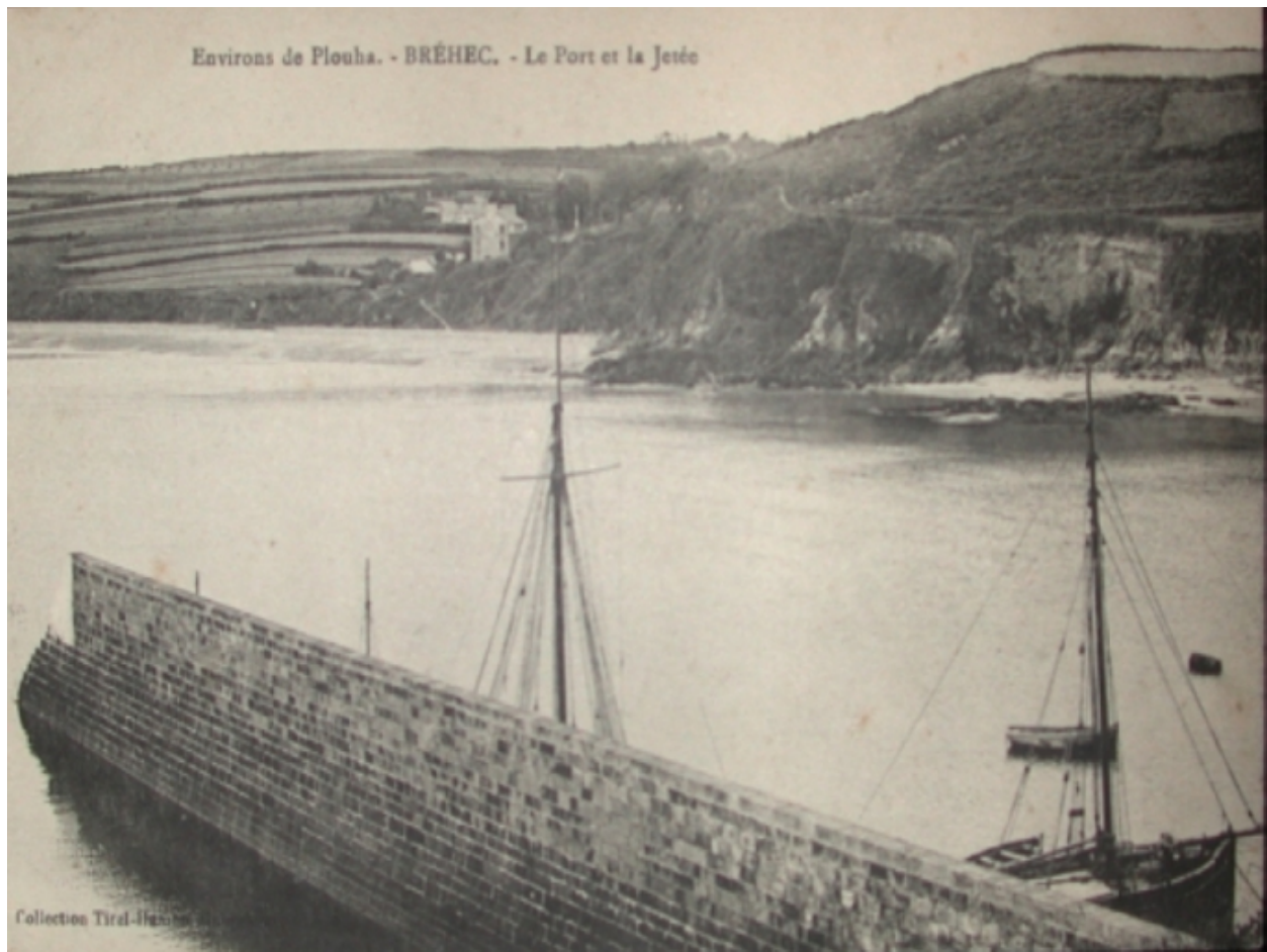
Carte postale de la digue-jetée du port de Bréhec (Barat, fin 19e siècle).
