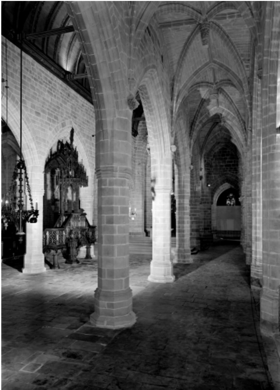
Vue du bas côté sud.
