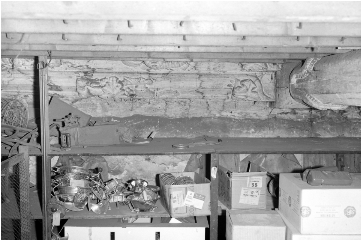
Troisième travée nord, sablière.
