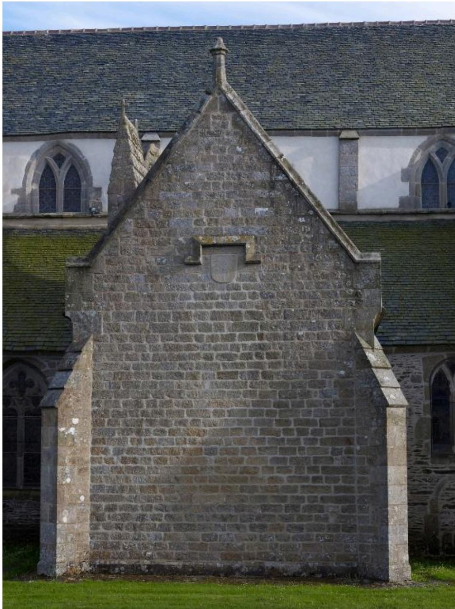
Chapelle nord. Pignon nord
