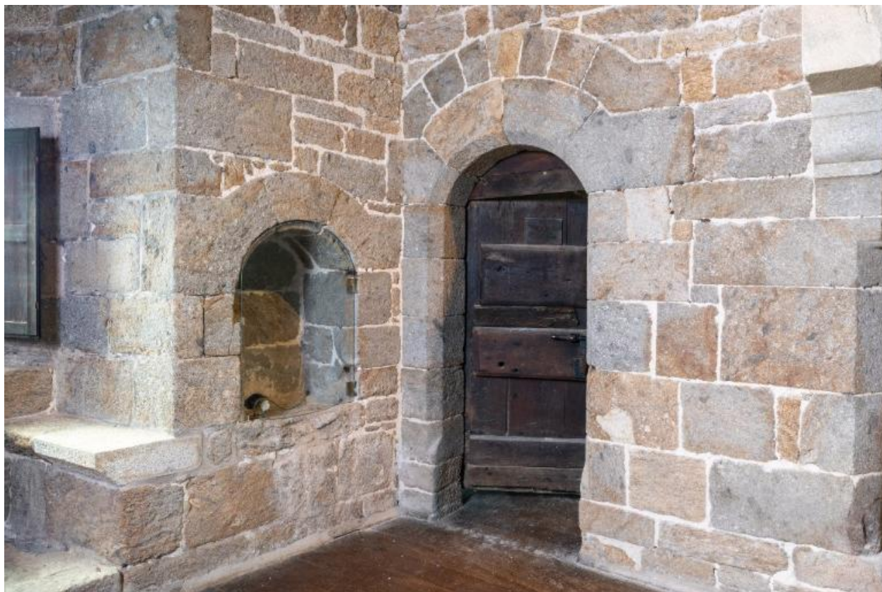
Vue intérieure de la tour Solidor : premier étage, pièce intermédiaire, placard mural (en arc plein cintre) et porte d'accès à la tour ouest
