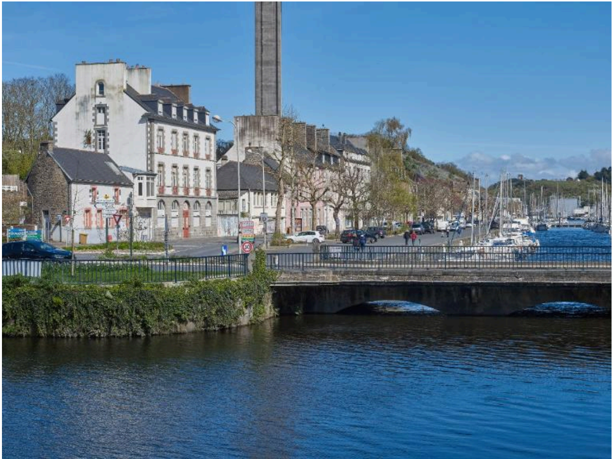
Le pont de pierre dans son environnement urbain et portuaire
