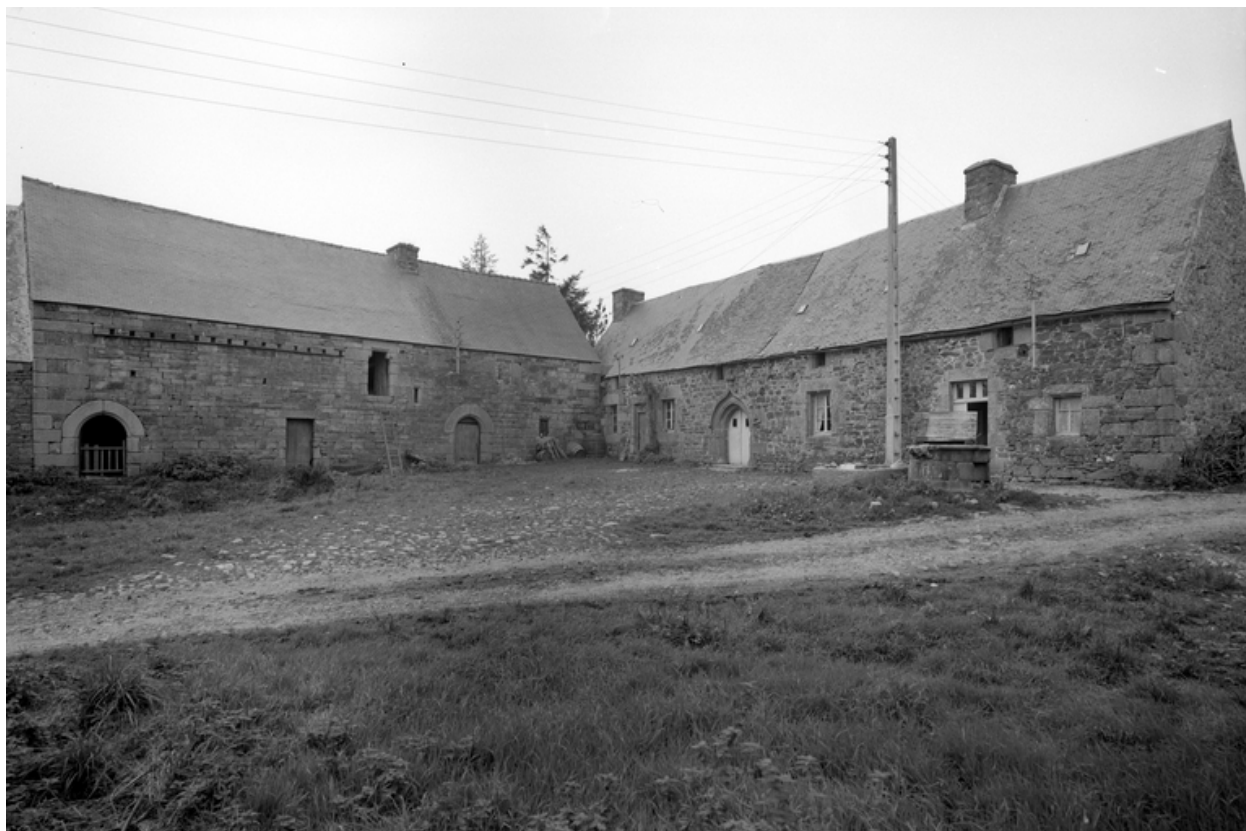
Vue générale vers le nord ouest
