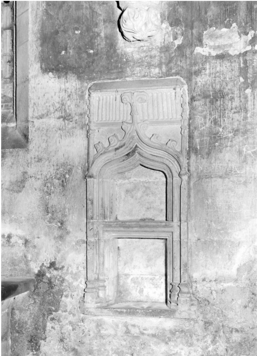
Croisillon sud, mur est, crédence.
