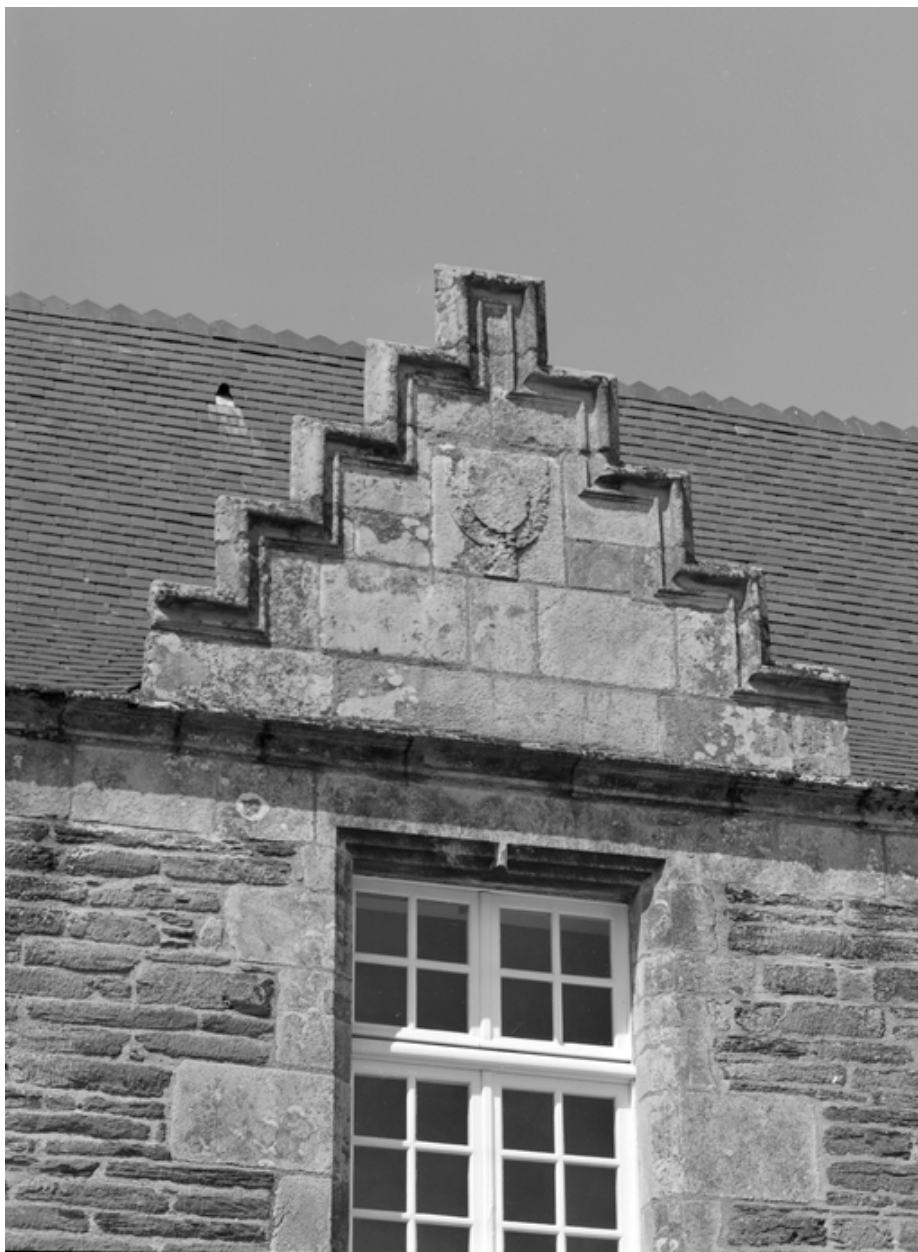
Aile nord, élévation sur cour, cinquième lucarne.
