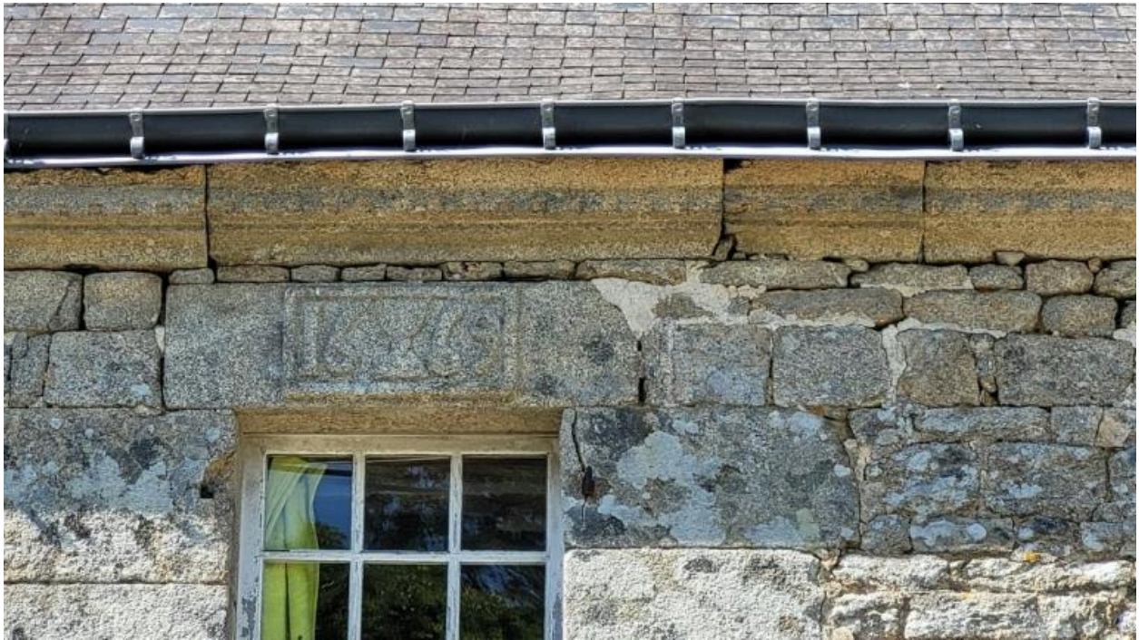
Linteau sculpté, façade sud
