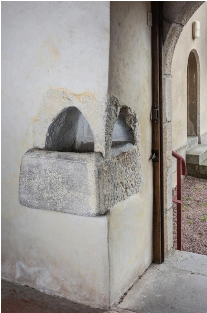
Bénitier en granite présent au niveau de l'entrée principale Sud
