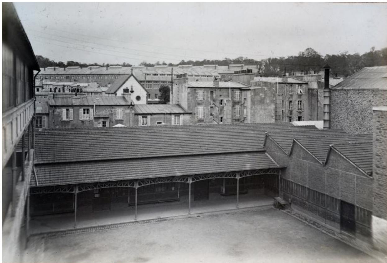
Préau, cour et ateliers de l'ancienne école pratique d'industrie à Brest.
