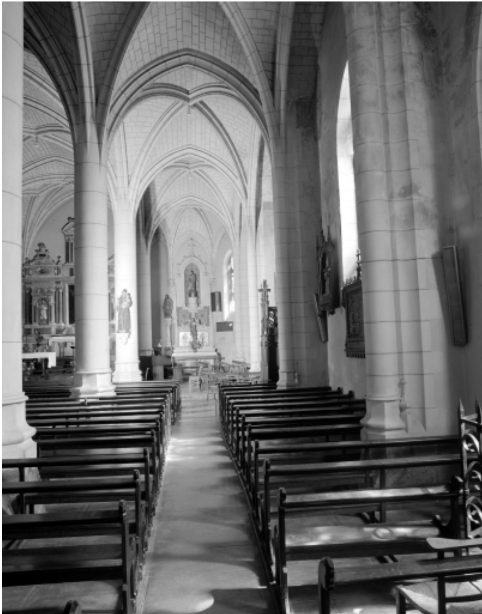
Bas-côté sud, vue générale vers l'est.
