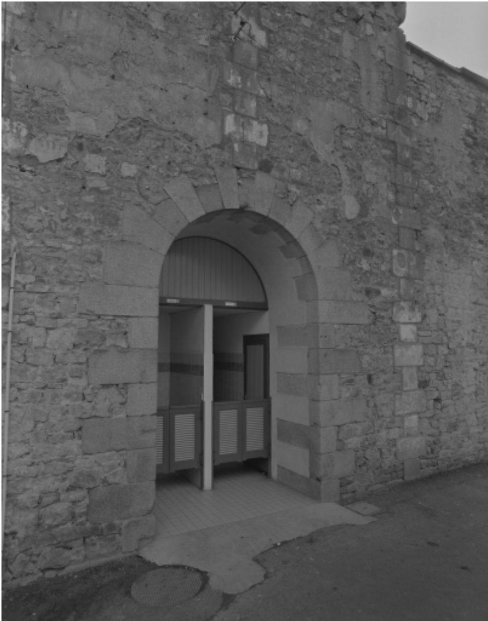
Elévation Est, porte : vue générale
