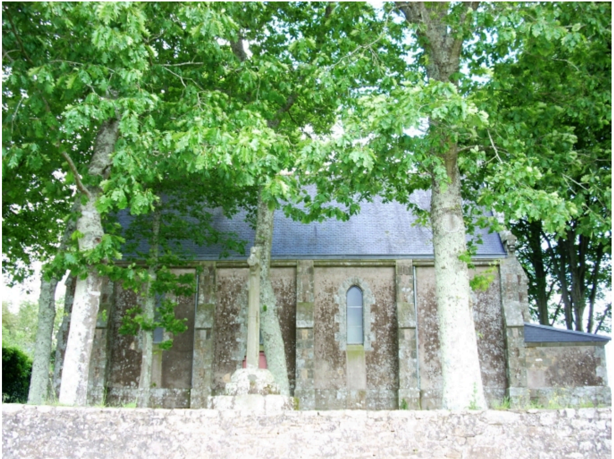
Quimper, chapelle de Cuzon : élévation sud
