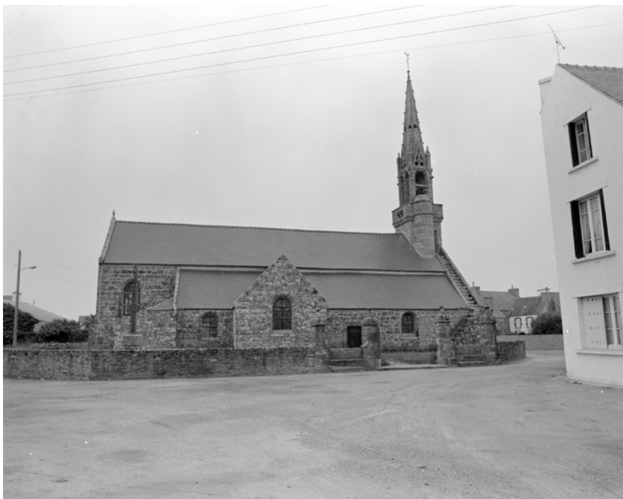
Vue générale de l'église prise du nord. (1979)
