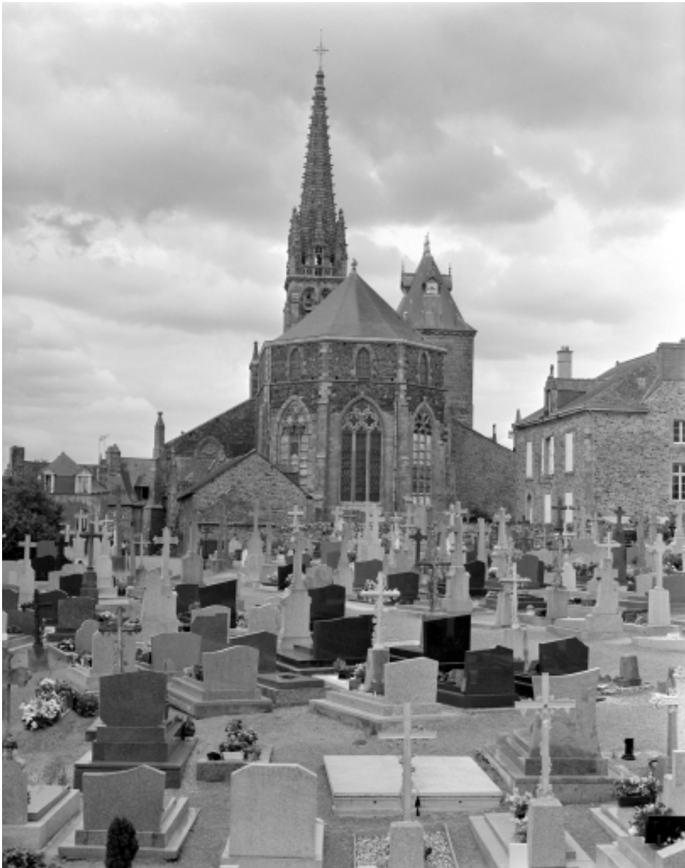
Elévation Ouest : vue générale
