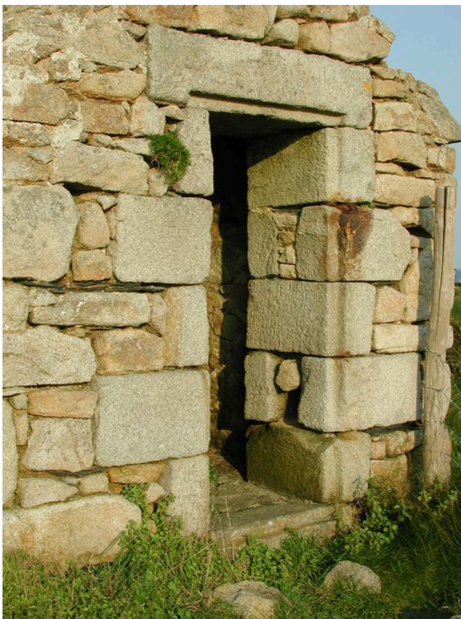
Santec, Ile de Sieck : vue de l'entrée de la poudrière
