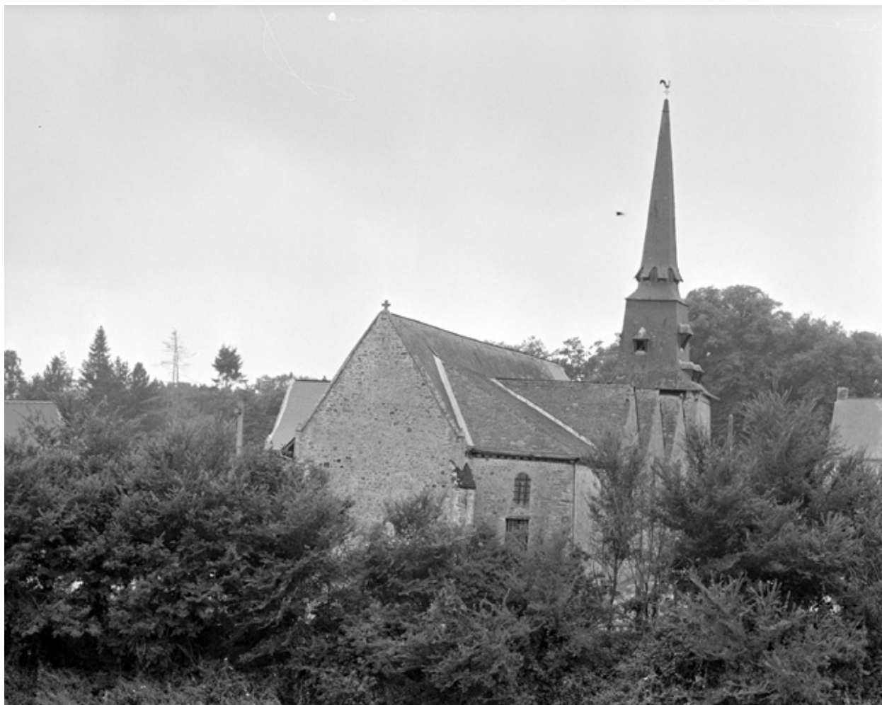
Chevet et façade nord
