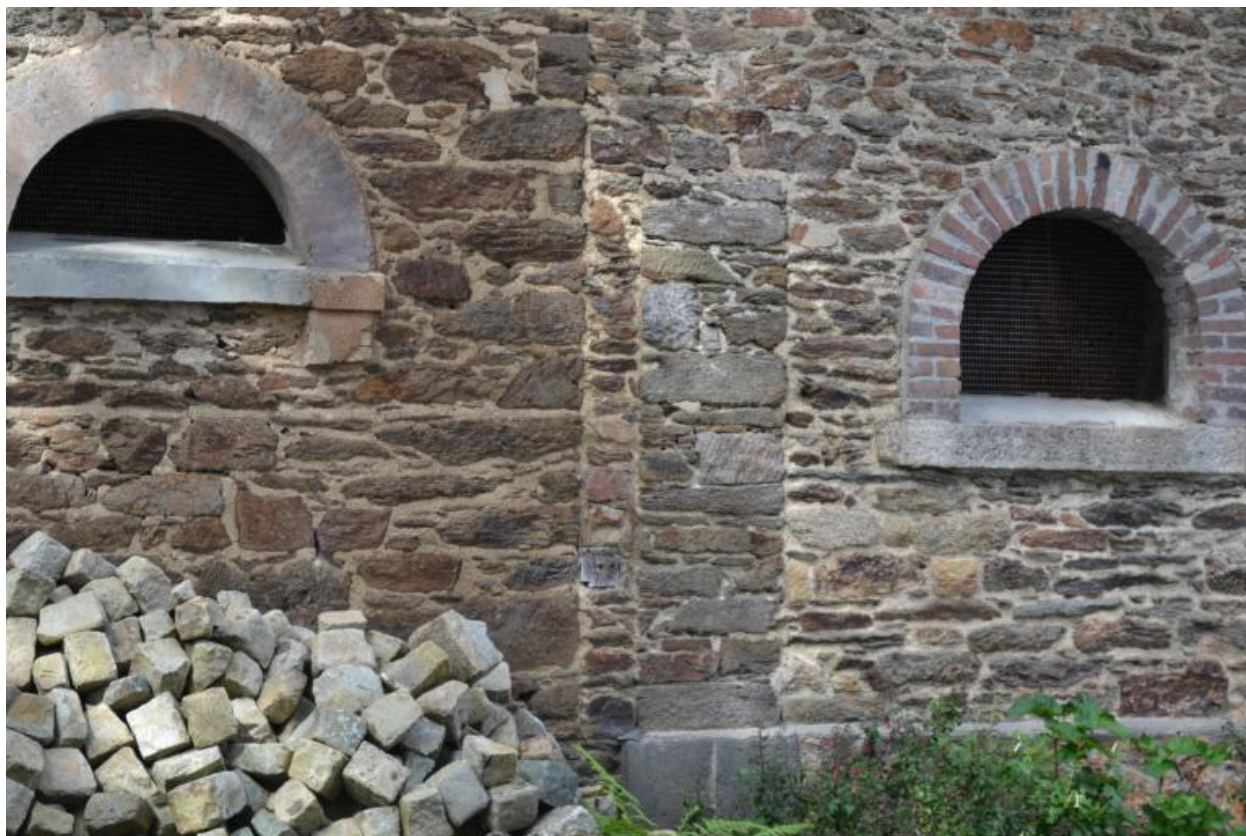
Blanchisserie du Leck. Façade sud. Détail d'un pilier englobé dans la maçonnerie
