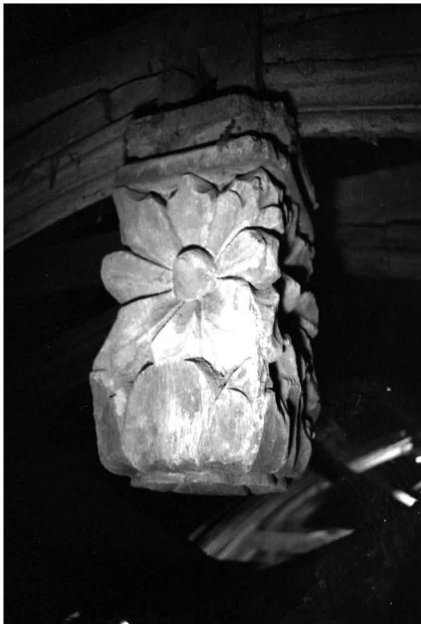
Charpente, détail de la clé 36.
