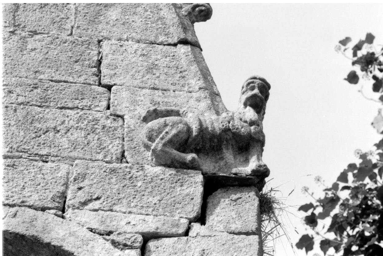
Fenêtre du mur est du bras sud : vue de la pierre d'assise nord
