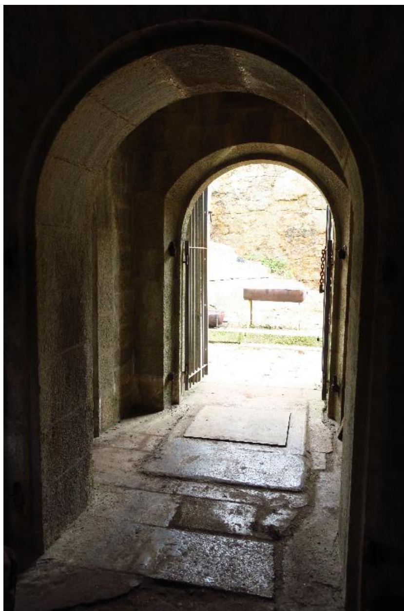
Archipel de Glénan, batterie de Penfret, corps de garde crénelé, porte et regard de la citerne.
